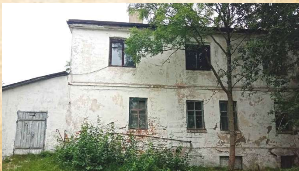
Будынак по адресе: вул.Свядлова, д.15 А.
